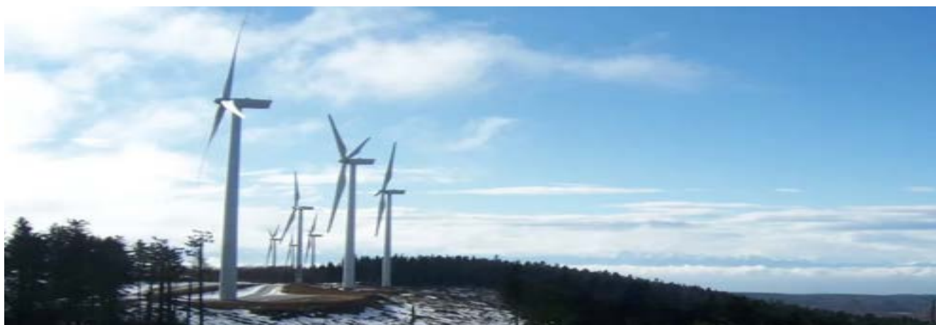
Parc éolien d'Arfons (Source : Région Occitanie)
