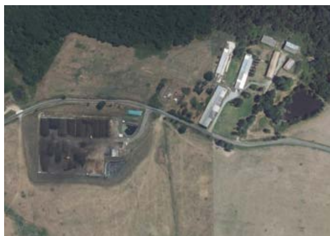
Plateforme de compostage de Labécède-Lauragais (Source : Géoportail)
