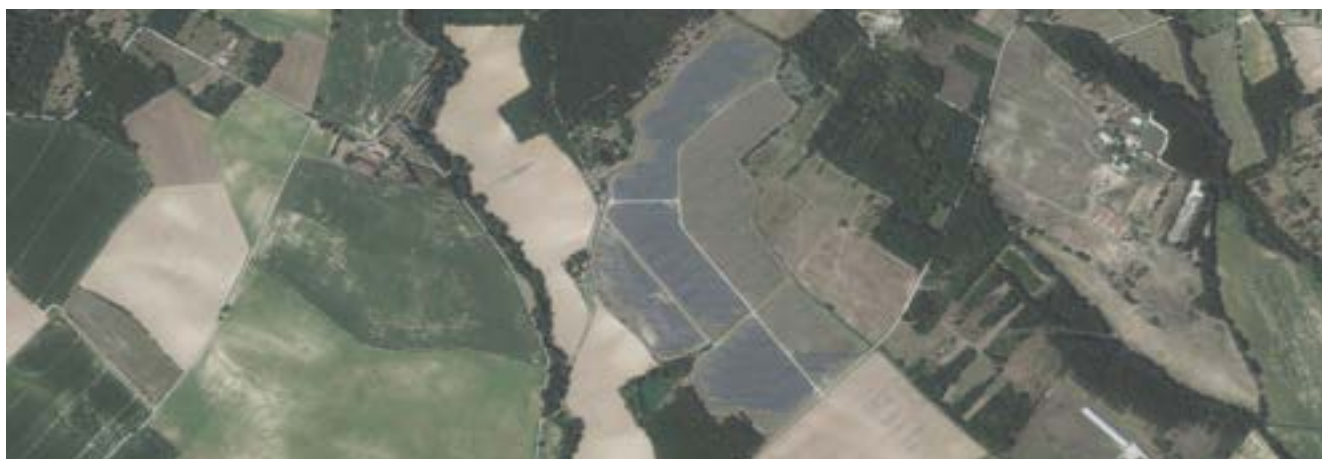
Centrale photovoltaïque de Saint-Martin-Lalande (source : Géoportail)
