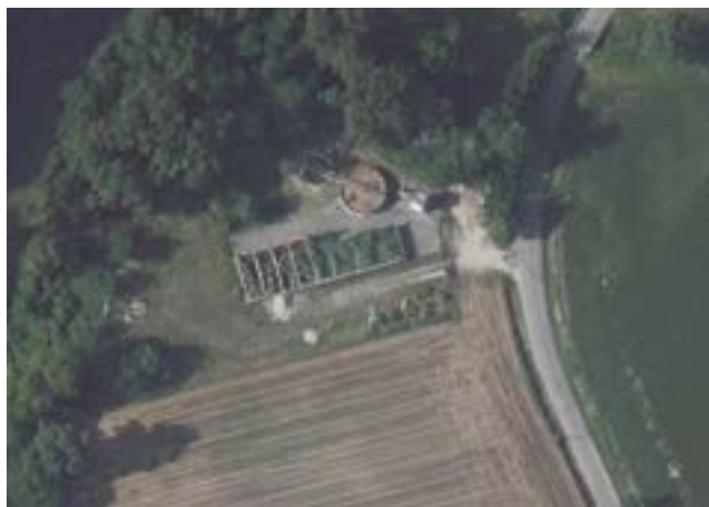
Station d'épuration de Belpech au bord de l'Hers Vif (Source : Géoportail)
