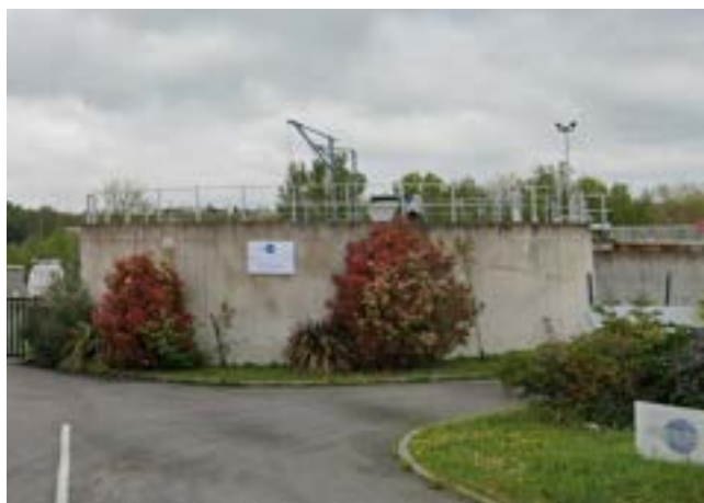
Station d'épuration de Villefranche-de-Lauragais (Source : Google Street View)
