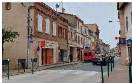
👉 Espaces publics partiellement requalifiés - linéaire très étiré et discontinu
