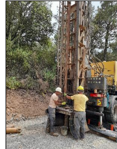
Forage de reconnaissance
