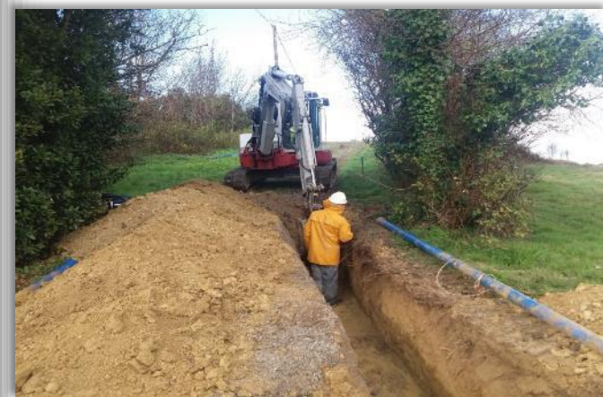
Sécurisation du secteur Belpec-Vixiège
