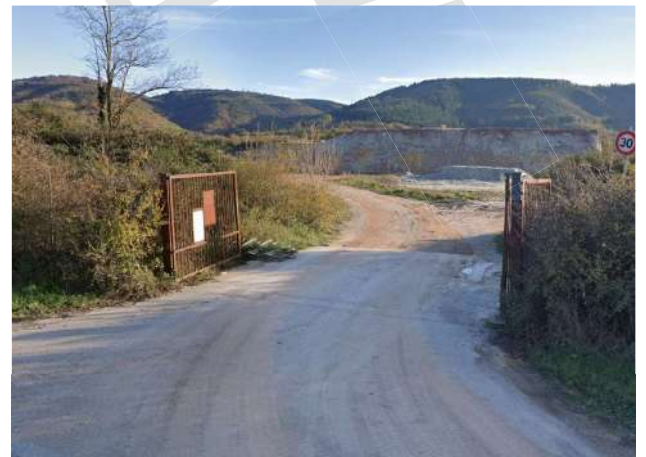
Carrière En Salvan, commune de Vaudreuille / StreetView
