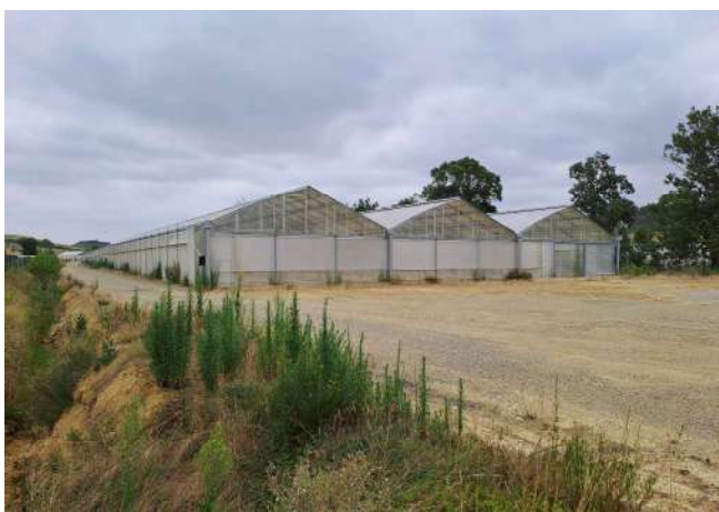
Centrale solaire de Vignes 1 / EVEN Conseil, août 2024
