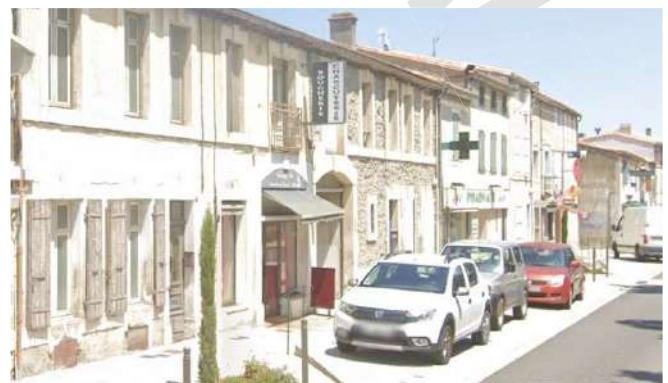
Traversée du centre-bourg de Montréal - StreetView
