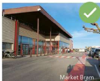
Chemins piétons matérialisés
