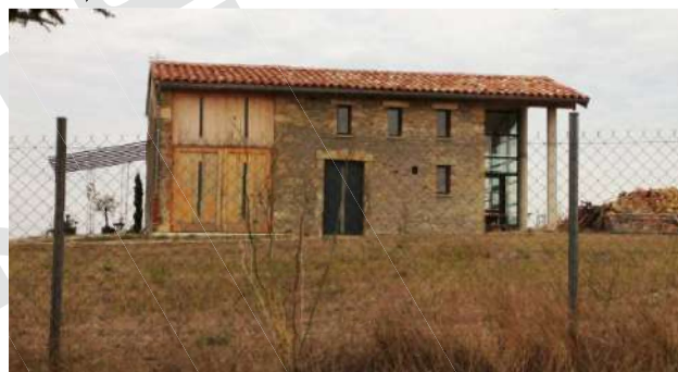
Les Casses, rénovation d'un bâti ancien
