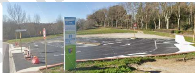
Travaux sur l'aire de covoiturage de Lanta en 2023
